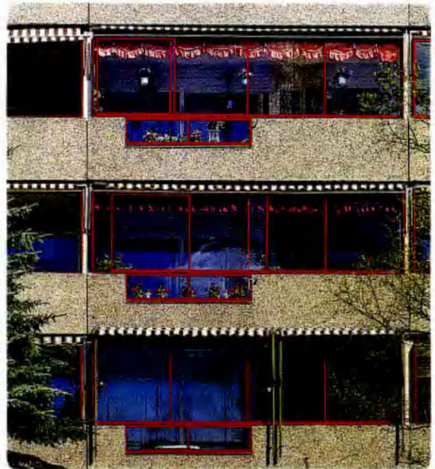
Fig. 71 Skyveglass montert på eksisterende brystning. Foto: SINTEF Byggforsk
