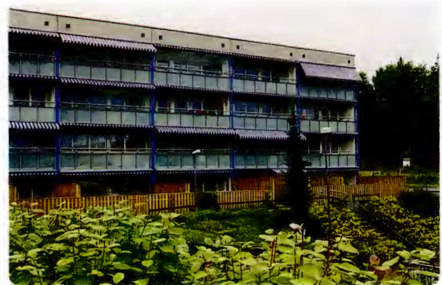
Fig. 72 Nytt brystningssystem tilrettelagt for innglassing av balkongen. Foto: Balkongforeningen i Norden
