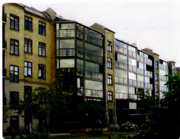
Fig. 514 b Heldekkende innglassingssystem montert utenpå balkonger Foto: SINTEF Byggforsk
