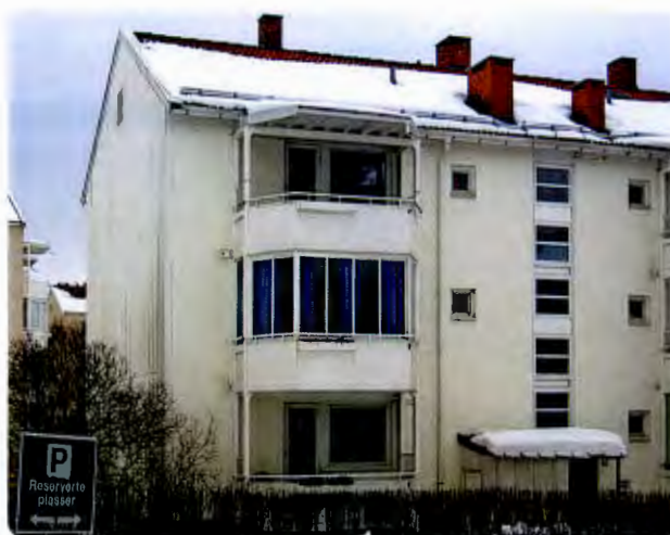
Fig. 512 b Innglassingssystem på eksisterende brystning. Foto: SINTEF Byggforsk
