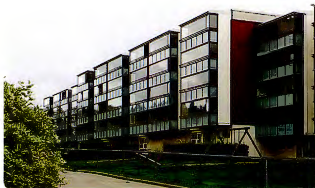
Balkongene på 1960-tallsbebyggelse er skiftet ut og supplert med innglassingssystem for hele fasaden. Den enkle fasaden er blitt svært forandret. Foto: Balkongforeningen i Norden
