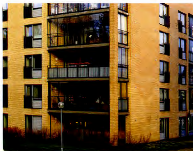
Fig. 513 Innglassingssystem innenfor eksisterende brystning som etasjehøyt element. Foto: SINTEF Byggforsk
